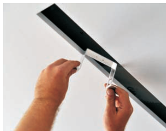
vložit hrazdy pro osazení reflektoru
