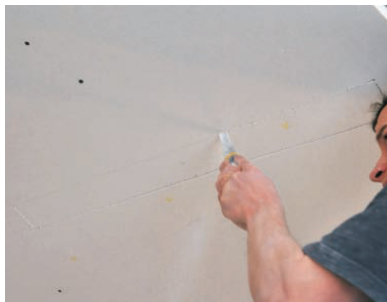
vyřezat otvory požadované délky, šířka montáž. otvoru je 85 mm
