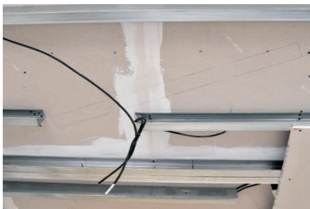
přerušit konstrukční profily v místě linie
