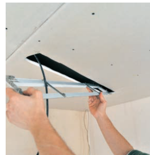
vložit linie do připraveného otvoru
