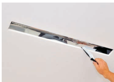
strhnout ochranou fólii z vnitřní strany profilu, odstraní se nánosy barvy a prachu na vnitřní ploše
