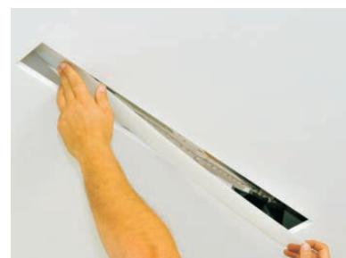
osadit plexisklo - pouze položit na očištěnou vnitřní plochu profilu
